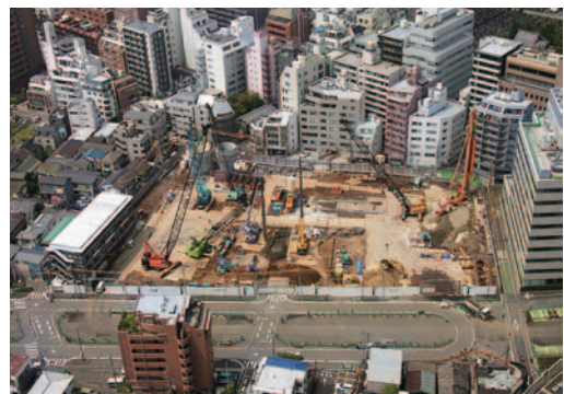
4月、新庁舎建設の様子
