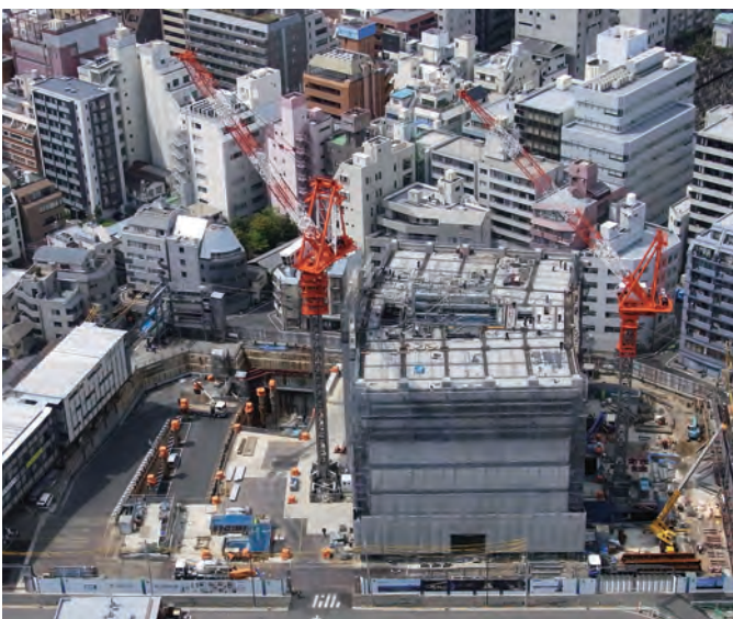
4月10日現在の新庁舎建設の様子
